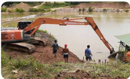
โครงการขุดลอกตะกอนบริเวณสูบน้ำพลังงานไฟฟ้ากลุ่มผู้ใช้บ้านร่องแดง หมู่ที่ 6 ตำบลน้ำชา อำเภอสองแฉ่ง จังหวัดแพร่
