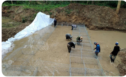
โครงการก่อสร้างฝายหินก่องเกเบี่ยนบริเวณลำห้วยแม่ลาน บ้านแม่ลานเหนือ หมู่ที่ 11 ตำบลห้วยอ้อ อำเภอลอง จังหวัดแพร่
