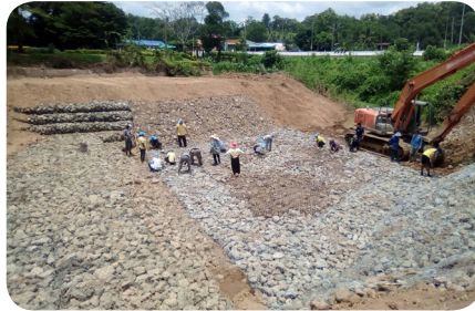
โครงการก่อสร้างฝายหินก่องเกเบี่ยนลำห้วยแม่พวก หมู่ที่ 4 ตำบลห้วยไร่ อำเภอดเด่นชัย จังหวัดแพร่
