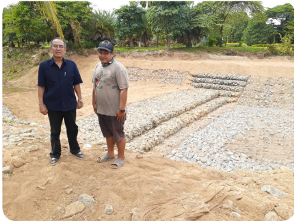
โครงการสร้างฝายก่องเกเบี่ยน บ้านน้ำแรม หมู่ที่ 4 ตำบลห้วยไร่ อำเภอดเด่นชัย จังหวัดแพร่
